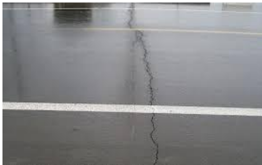
Gambar 2.6 Retak Sambungan jalan (Bina Marga No. 03/MN/B/1983)
