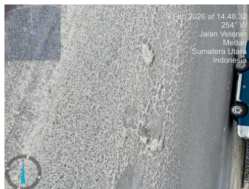
Gambar 2.7 Gambar Retak Kulit Buaya (Jln Veteran ,2026)
