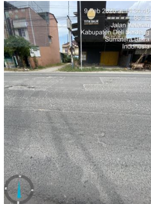
Gambar 2.8 Retak Memanjang(Jln Veteran ,2026)
