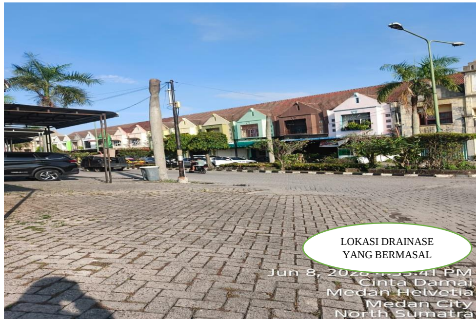
Gambar 3.2 Lokasi Drainase yang Bermasalah (Sumber : Google Maps).
