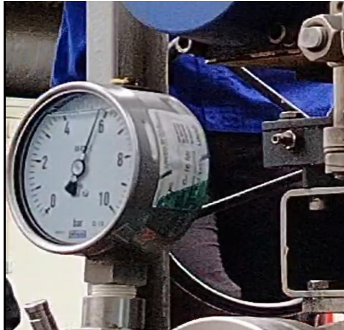
Gambar 4.6 Pressure Indicator pada Pipe Fuel Oil
