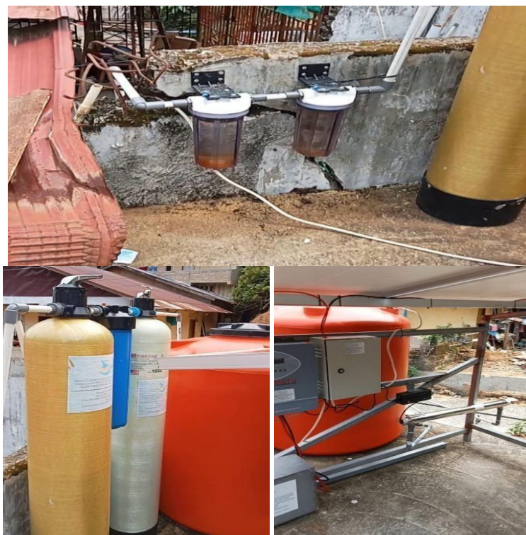
Gambar 4.13 Hasil Pembuatan Sistem Filtrasi Air
