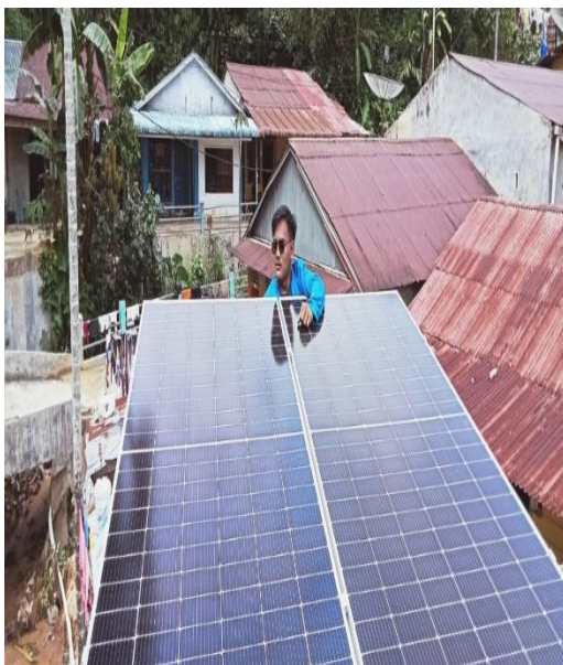
Gambar 4. 2 Pemasangan Panel Surya
