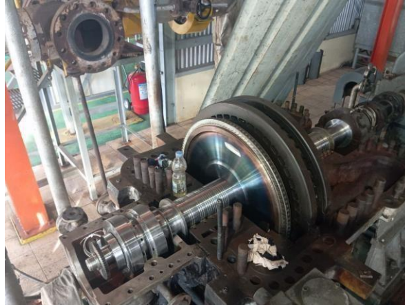
Gambar 4.3 Proses Pembongkaran Journal Bearing
