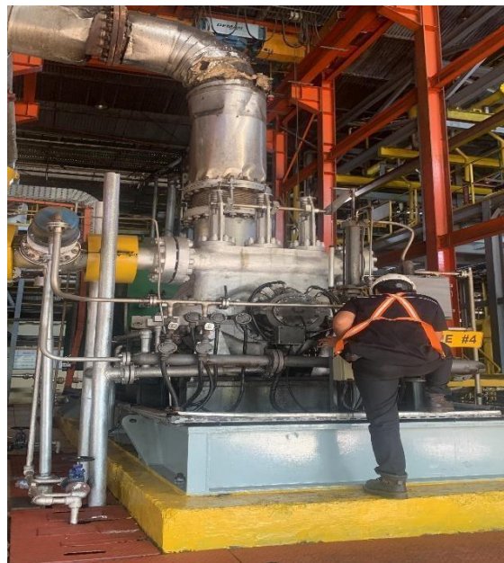
Gambar 4.7 Comisioning Sebelum Tes Run Turbin
