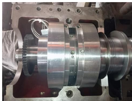
Gambar 4.5 Pemasangan Bearing Baru
