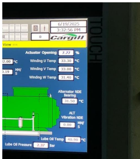
Gambar 4.12 Tekanan Oli Sebelum perbaikan melalui Panel
