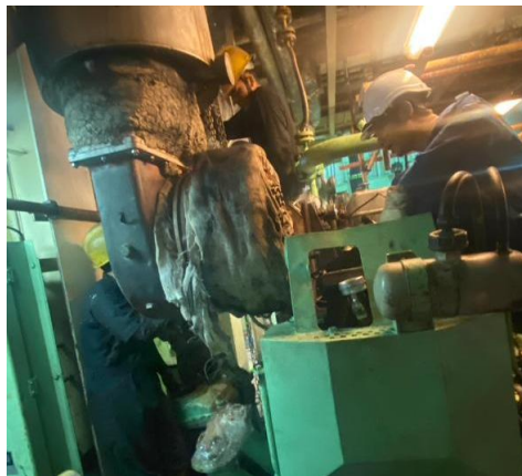
Gambar 4. 3 pelepasan turbocharger
