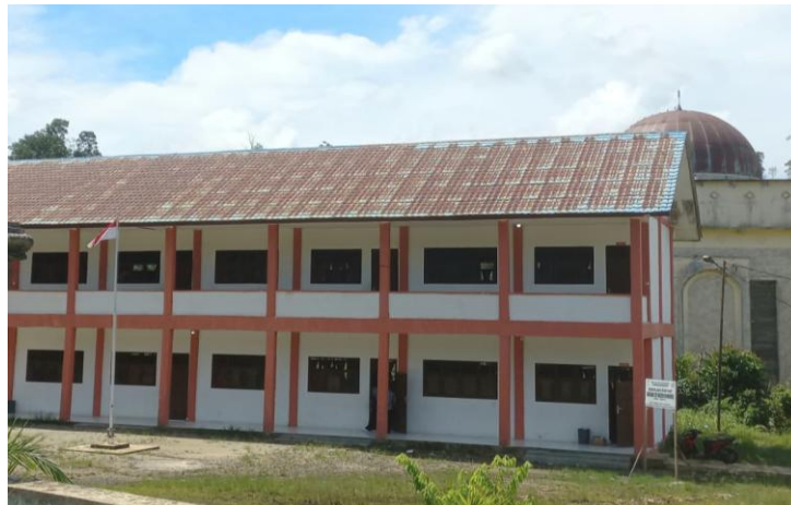
Gambar 3.1 Sekolah Rakyat Desa pangkalan Sulampi, Kecamatan Suro Makmur, Kabupaten Aceh Singkil
