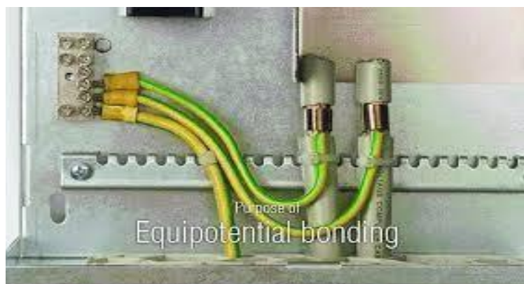
Gambar 2. 6 Equipotential Bonding
