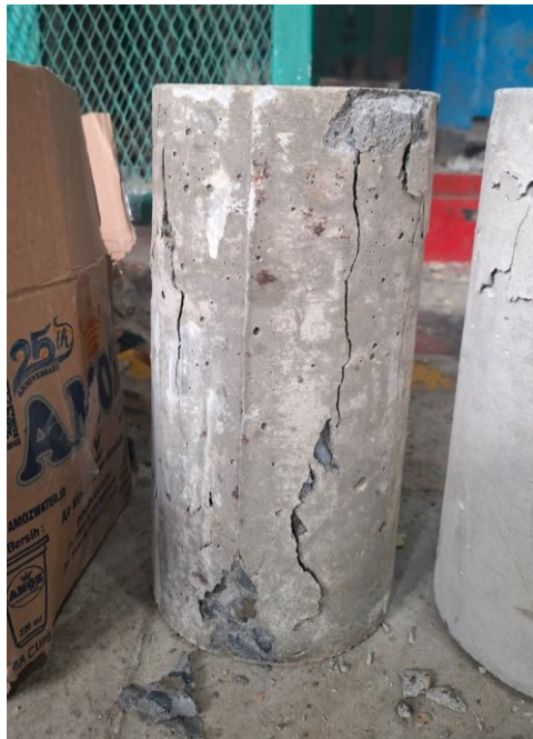
Gambar L.8 Benda Uji Setelah di Tes
