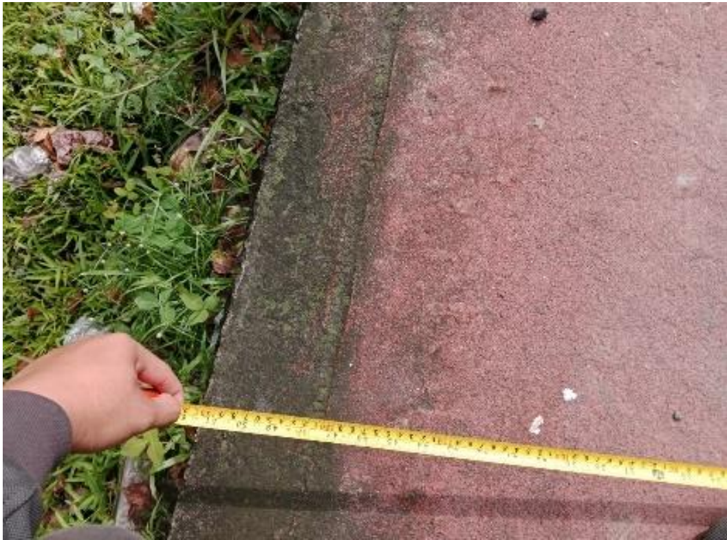
Gambar L 10 : Pengukuran Lebar Trotoar Jalan
