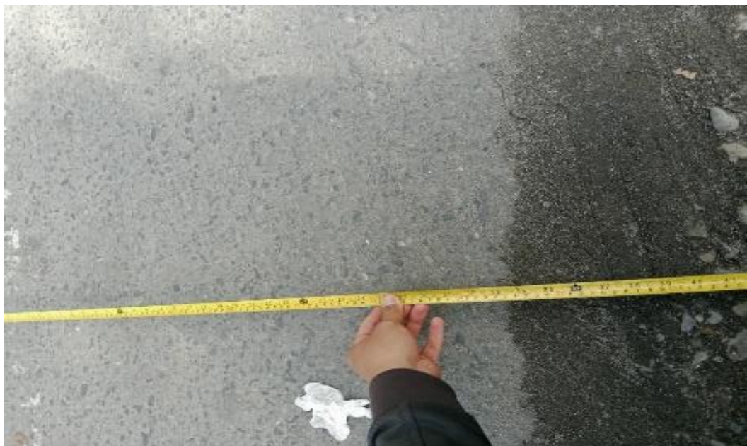
Gambar L9: Pengukuran Lebar bahu Jalan
