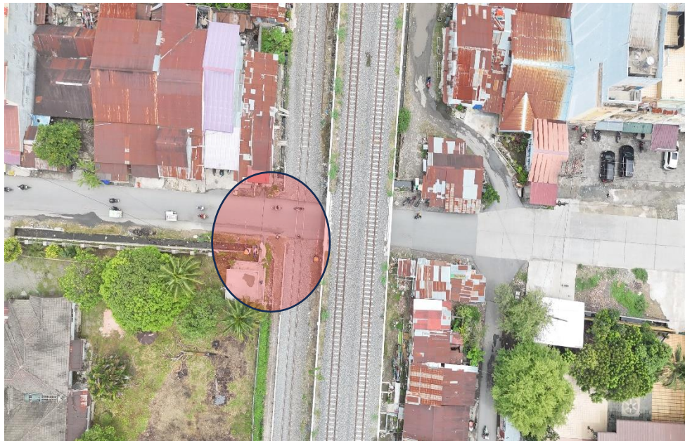
Gambar 4.2: Kondisi JPL 05 Km 3+594 s.d Km 3+600 (Sumber Dokumen Penulis)
