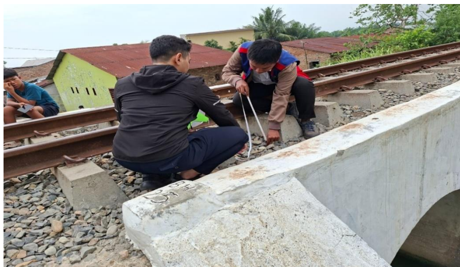
Gambar 4.9: Kondisi Balas BH 23 (Sumber Dokumen Penulis)
