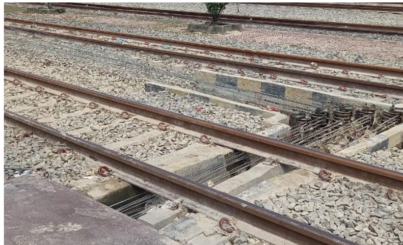
Gambar 2.3: Jalan Rel (Dokumen Penulis)
