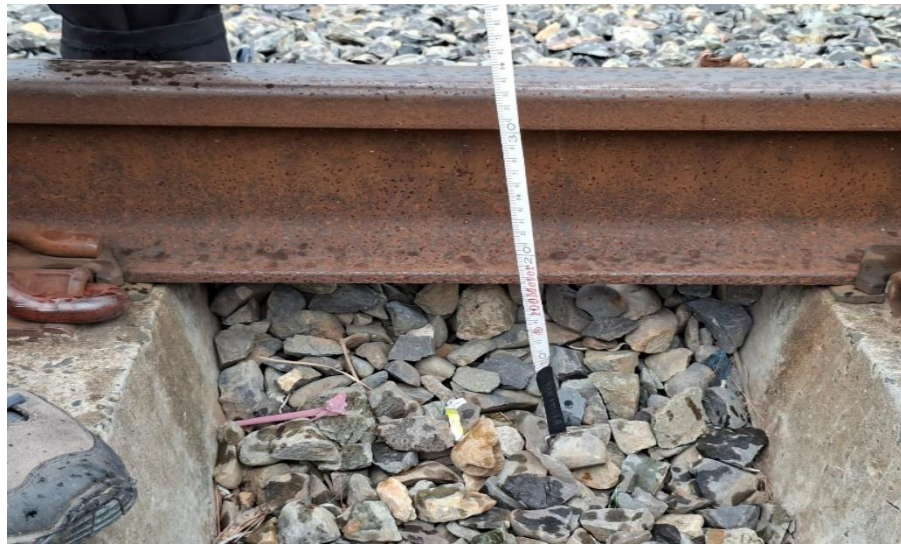
Gambar 4.7: Kondisi Balas Lurusan (Sumber Dokumen Penulis)
