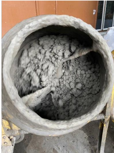
Gambar L.8: Pencampuran Material Menggunakan Mixer.
