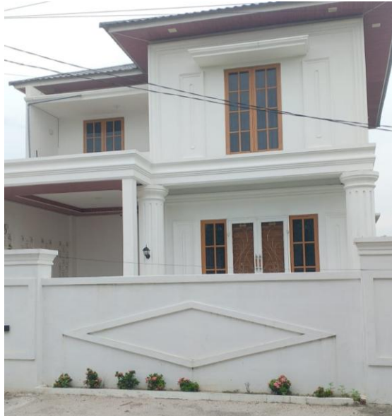
Gambar 4.1. Bangunan struktur beton
