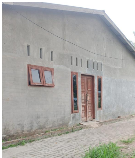
Gambar 4.2. Bangunan semi permanen (bata)
