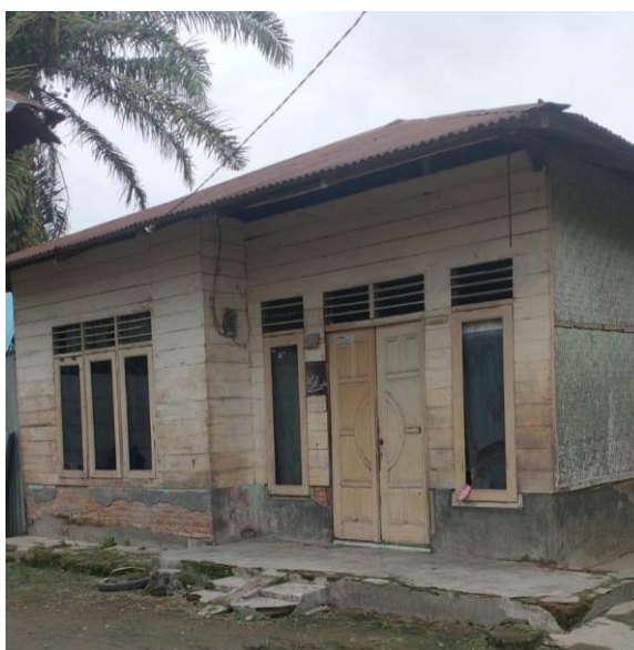
Gambar 4.3. Bangunan struktur non-permanen (gedek)
