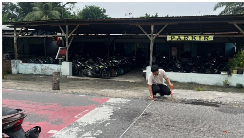
Gambar L.4: Pengukuran Lebar Jalan
