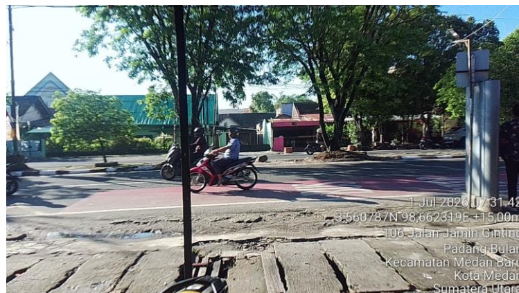
Gambar L4: Kondisi Fisik Titik Tunggu Bus Listrik.
