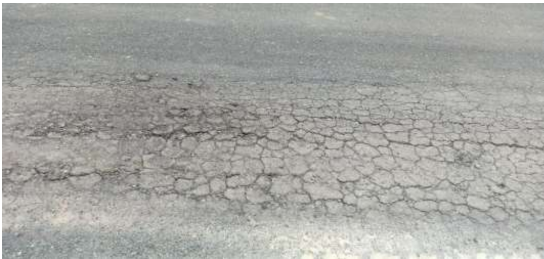
Gambar 2.7: Retak Kulit Buaya
