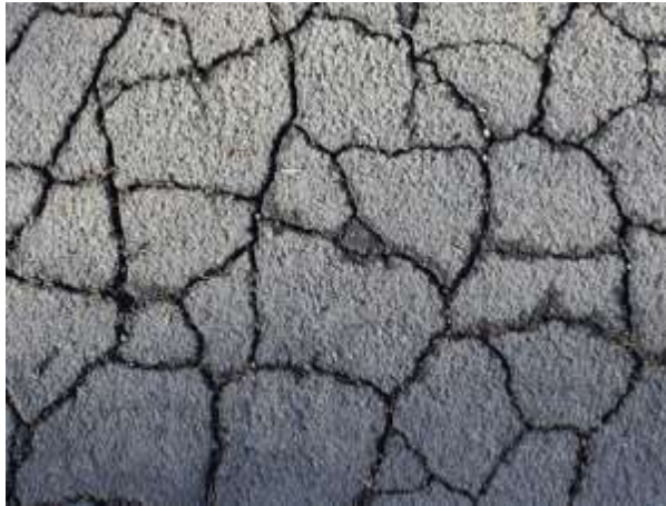
Gambar 2.9: Retak Blok
