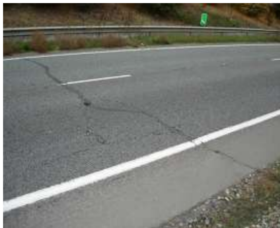
Gambar 2.13: Retak Reflektif Sambungan
