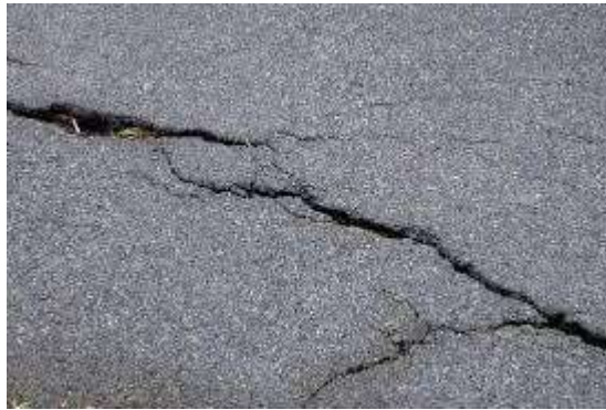
Gambar 2.15: Retak Memanjang dan Melintang
