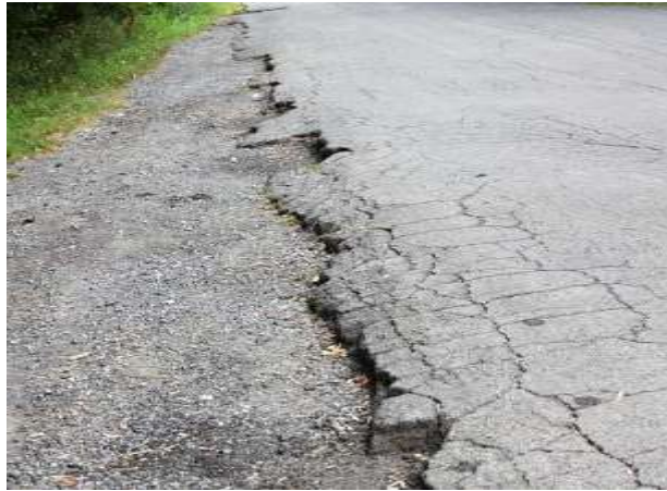
Gambar 2.12: Retak Pinggir
