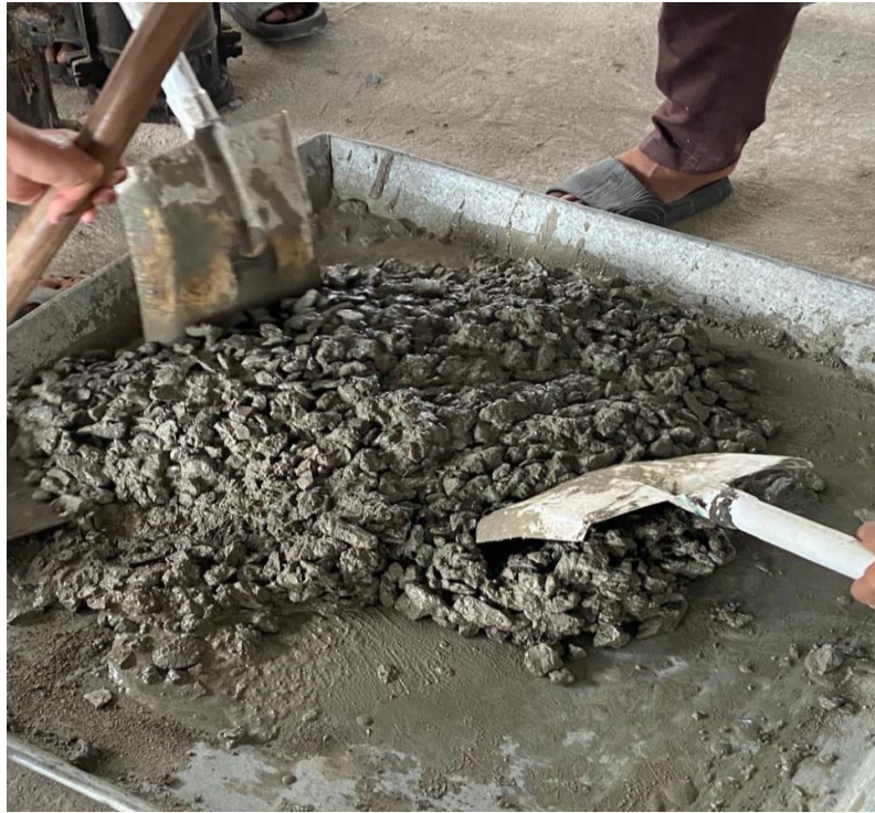
Gambar L.5: Proses pembuatan beton secara manual.
