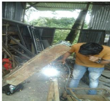
Gambar 3.11 Menghubungkan Benda Kerja
