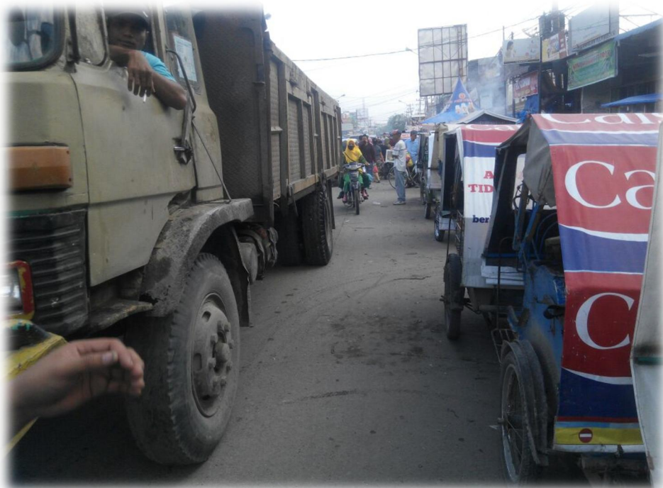
Gambar L.4: Keadaan ruas jalan dengan hambatan samping yang tinggi.
