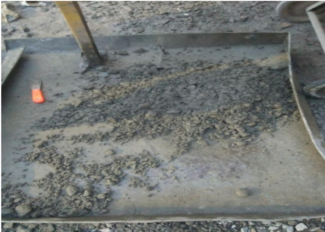
Stelah di lakukn pencampuran (setelah mix)
