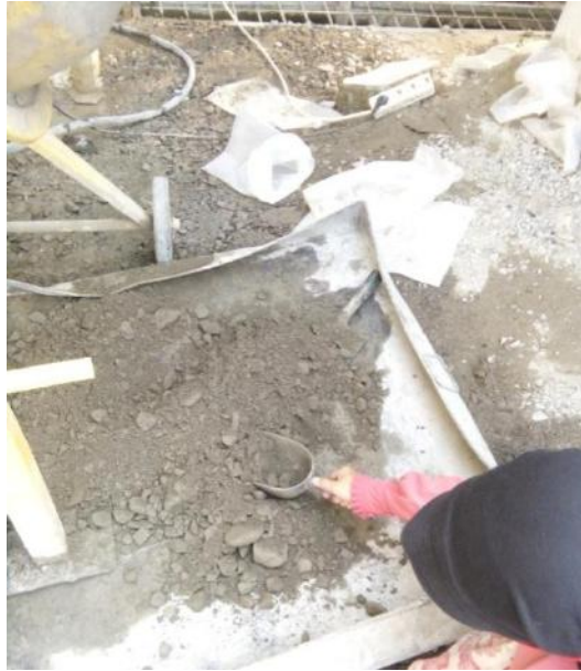
Gambar L7: Proses pencampuran agregat.
