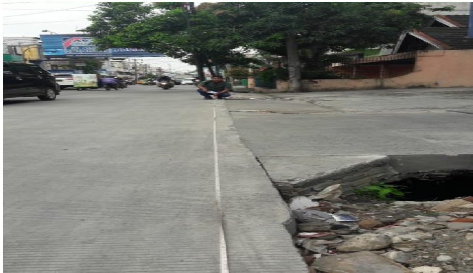
Gambar L.1: Pengukuran panjang jalan yang di survei.
