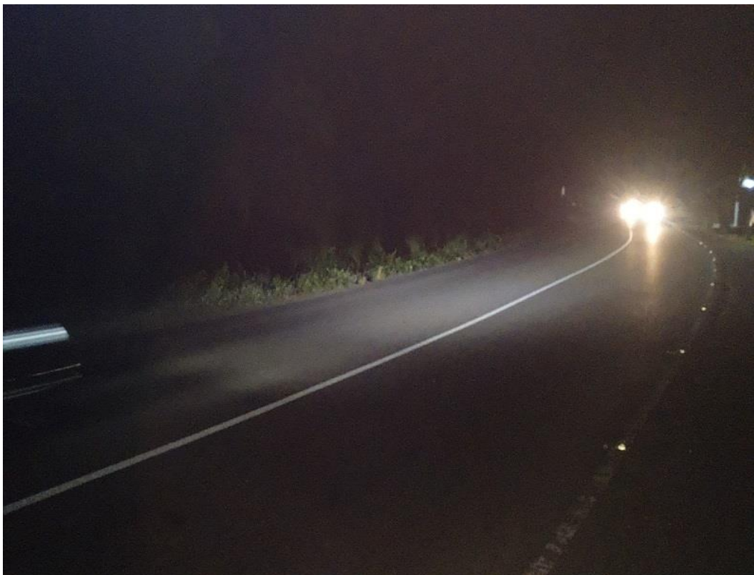
Gambar L.8 : Keadaan Jalan Lintas Sumatera, Bireuen, Aceh Pada Malam Hari Tanpa Lampu Jalan
