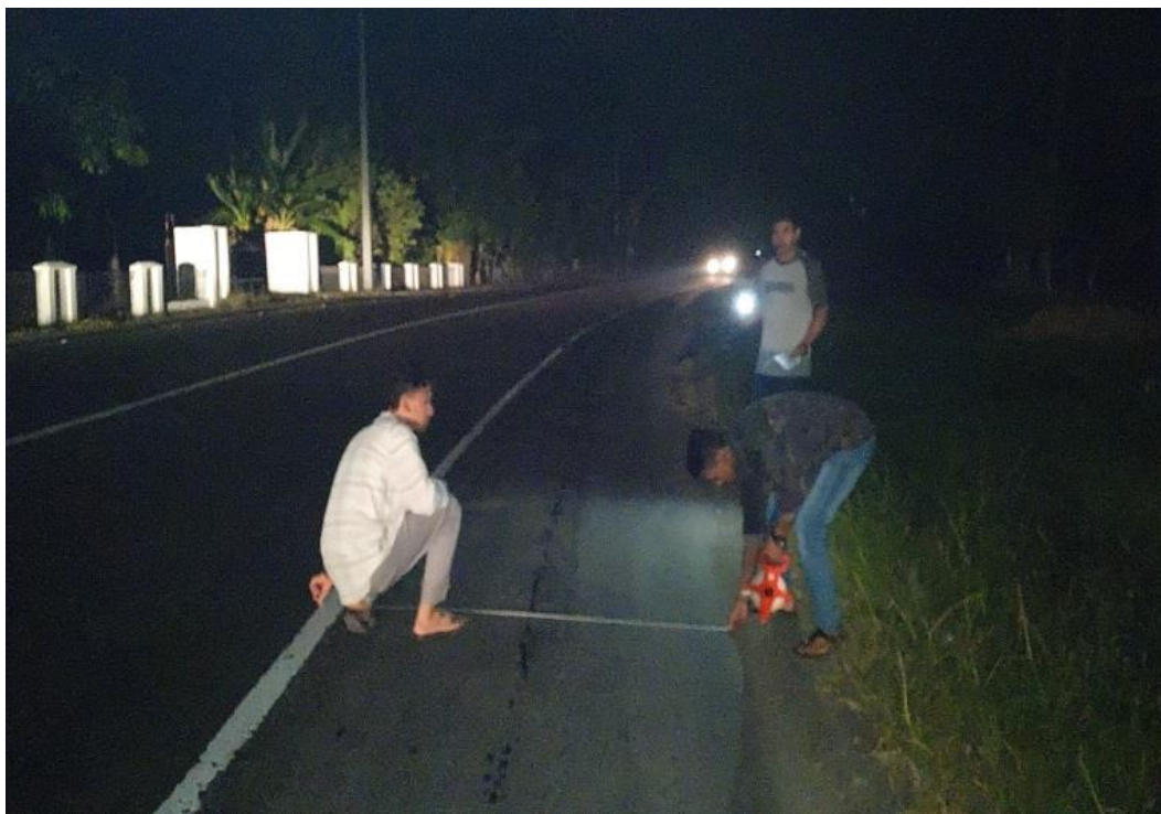
Gambar L.5 : Pengukuran Bahu Jalan Lintas Sumatera, Bireuen, Aceh
