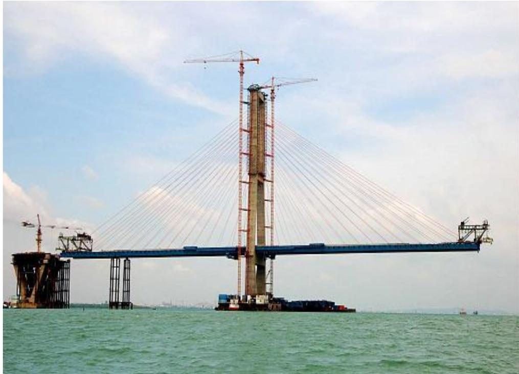
Gambar 2.6. *Crane* jembatan.
