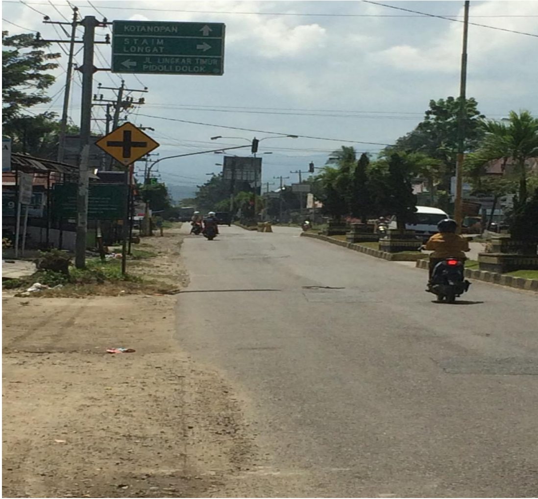
Gambar L.2: Rambu jalan sebagai tanda arah ke Kecamatan Kotanopan.
