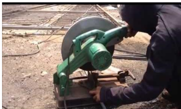
Gambar 4.10 proses pemotongan pipa besi
