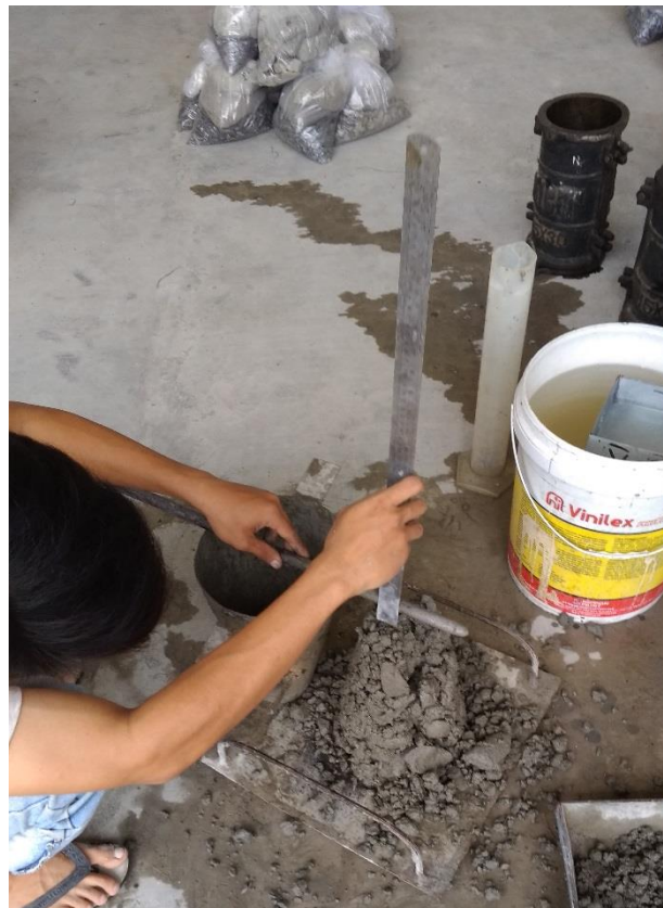
Gambar L.7. Proses pengujian slump .
