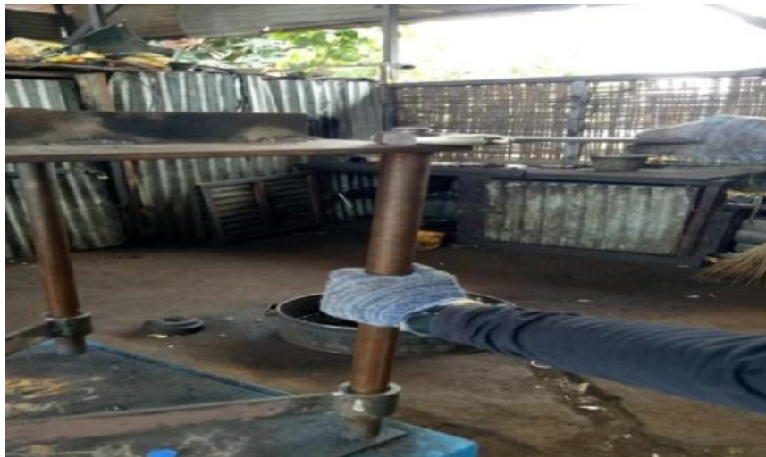
Gambar 4.26 Pemasangan Plat Atas
