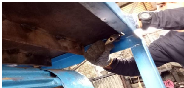
Gambar 4.24 Proses Penyambungan Tiang Dan Plat Bawah
