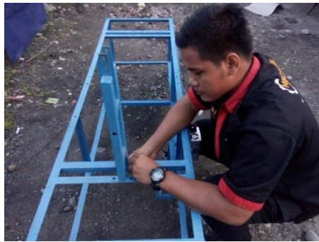
Gambar 3.30 Memasang Tiang Panel
