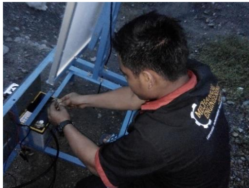
Gambar 3.33 Memasang Baterai
