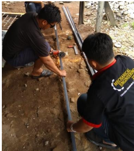
Gambar 3.23 Pemotongan Besi
