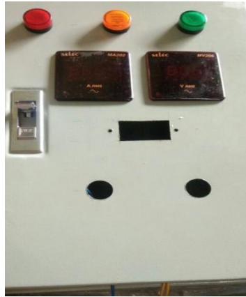
Gambar 4.8 Hasil pemasangan amprometer dan voltmeter pada panel
