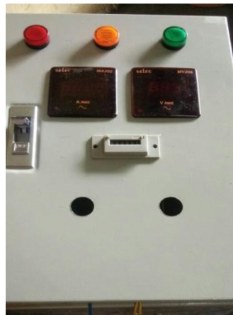
Gambar 4.9 Hasil pemasangan counter pada panel
