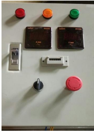
Gambar 4.10 Hasil pemasangan tombol emergency dan tombol switch reverse
