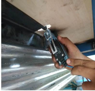
Gambar 4.14 Pemasangan limit switch pada mesin roll
