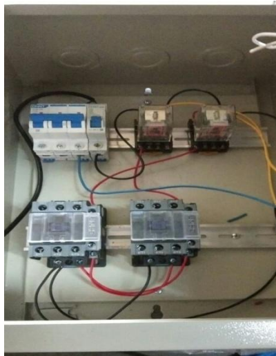
Gambar 4.13 Hasil pemasangan magnetic contactor
