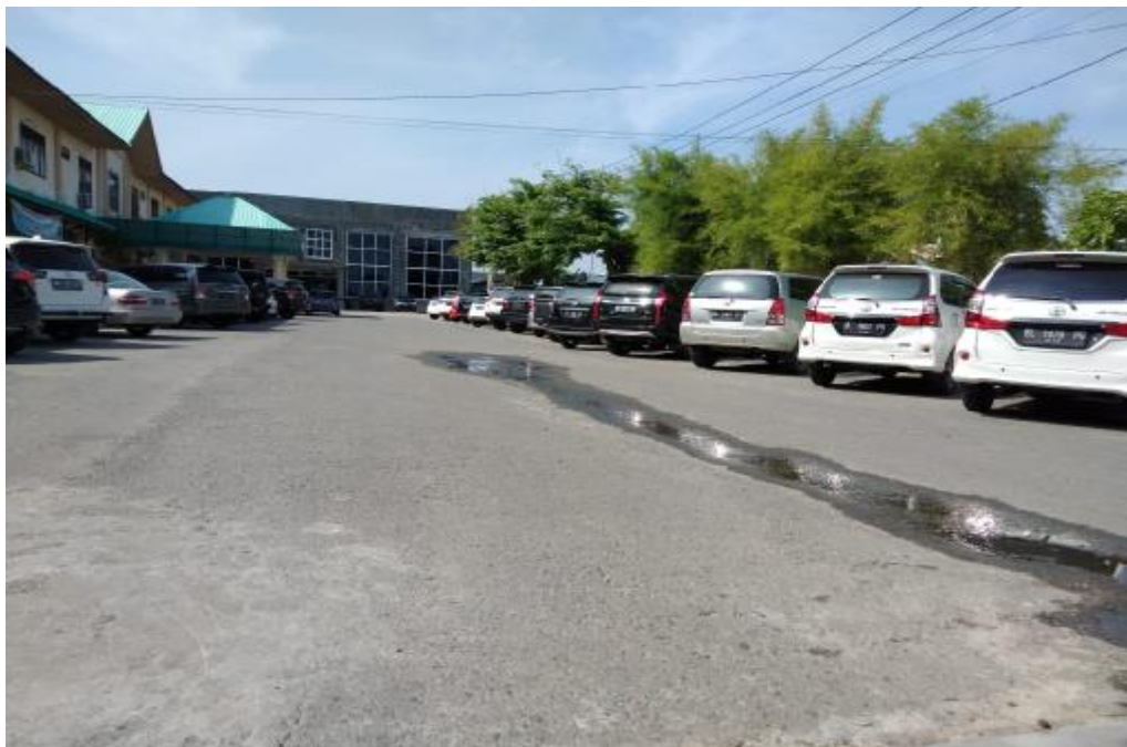
Gambar L4: Dokumentasi kondisi lahan parkir mobil R.S.U Tgk Chik Ditiro Kota Sigli (Survei lapangan 2019).
