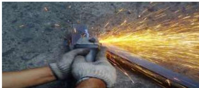
Gambar 4.10 Proses Pemotongan Bahan
