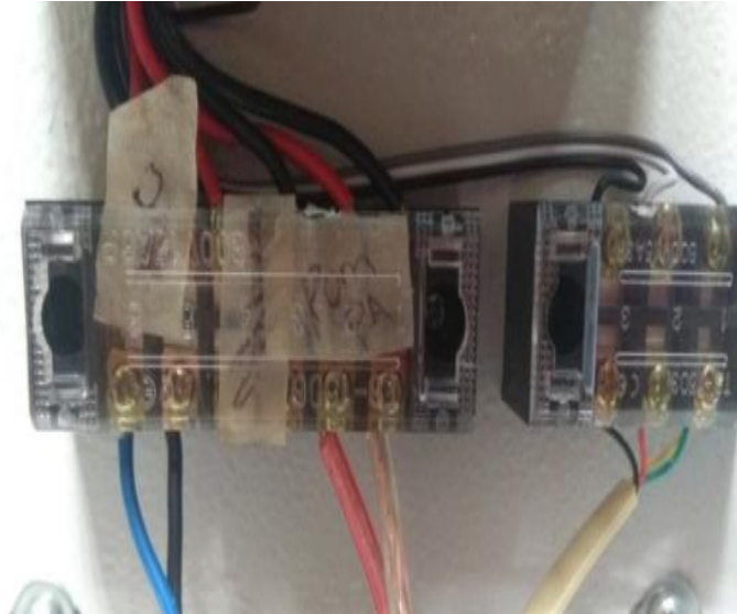
Gambar 3.9. Terminal blok
