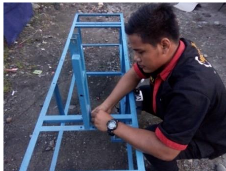
Gambar 3.25 Memasang Tiang Panel
