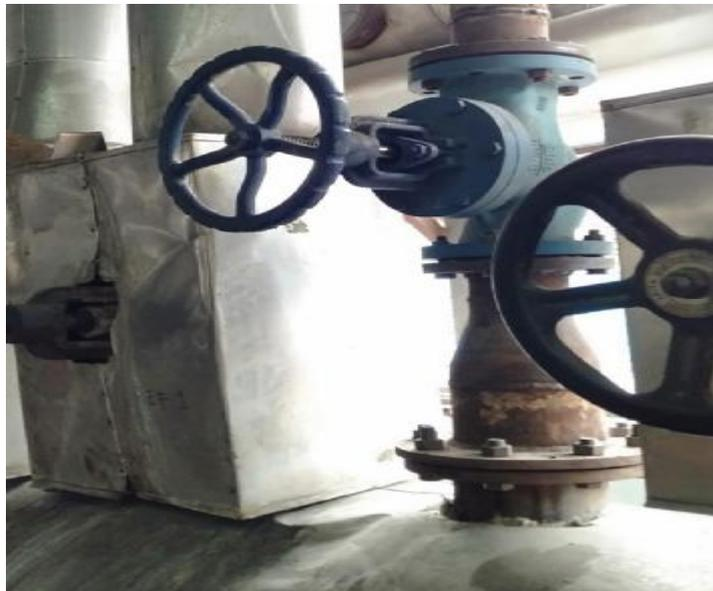
Gambar 4.2 Valve Venting Udara
