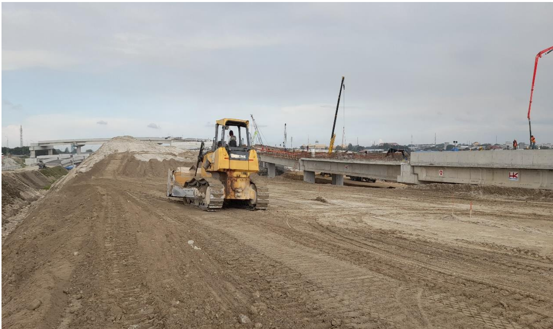
Gambar L.4: Alat berat bulldozeri
