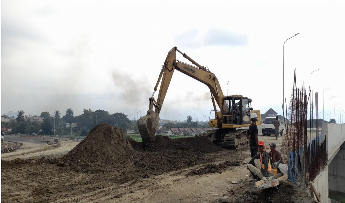
Gambar L.5: Alat berat excavator
