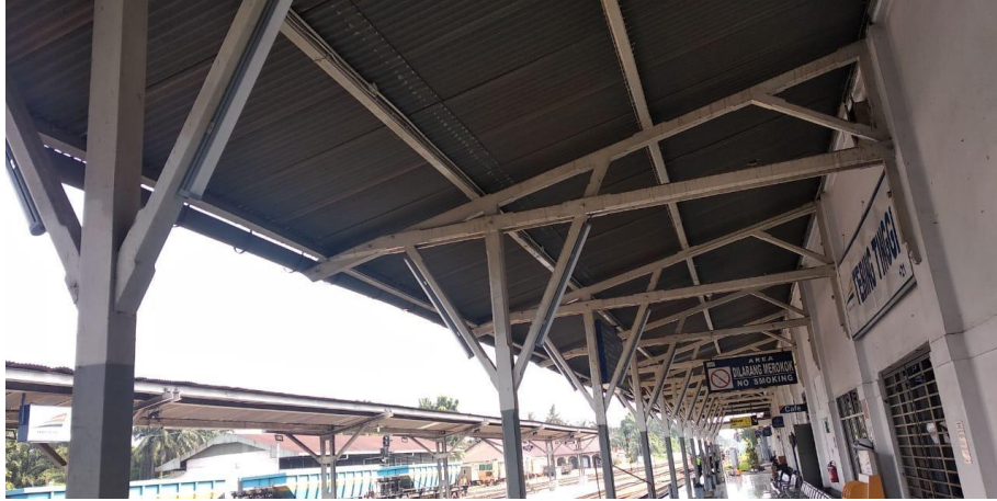
Lampiran 1 Area Ruang Tunggu Stasiun Tebing Tinggi
