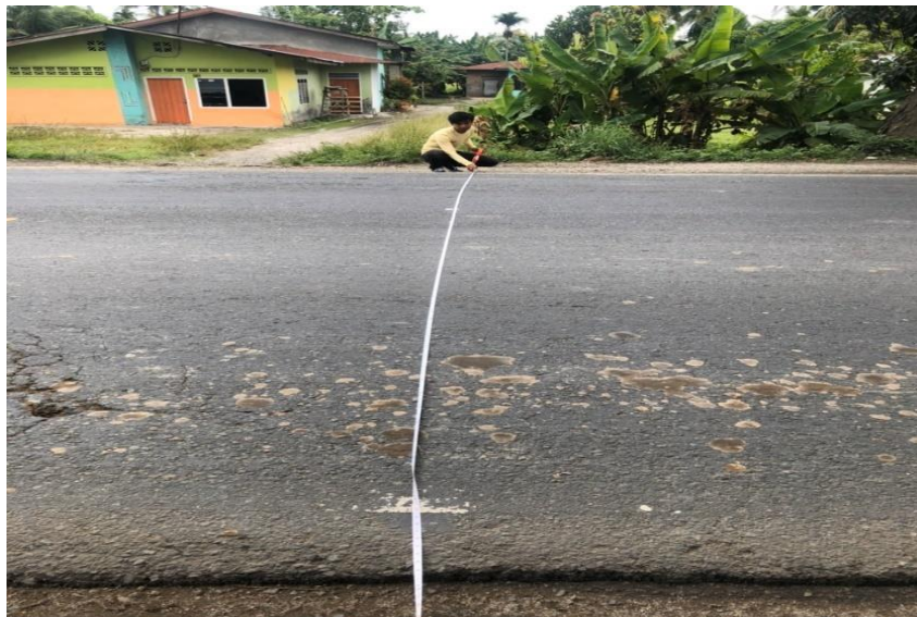
Gambar 5.2 :Dokumentasi pengukuran badan jalan
