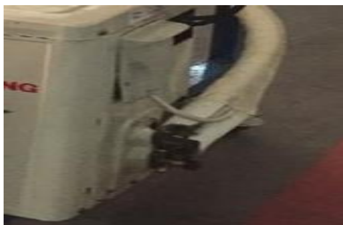
Gambar 4.8 Kabel koneksi unit indoor dan outdoor
