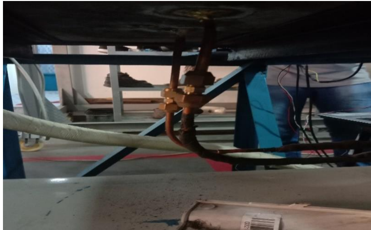
Gambar 4.10 Pipa masuk kompresor
