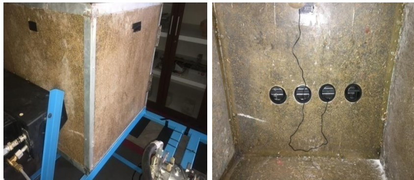
Gambar 3.21 Pembuatan Lubang dudukan evaporator
