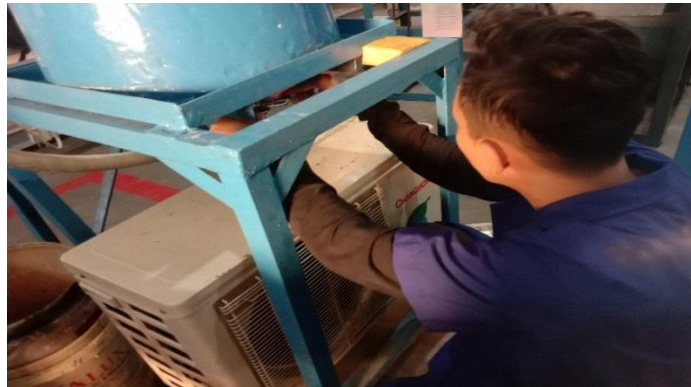
Gambar 4.19 proses penyambungan Alat Penukar Kalor ke Jalur Refrigeran
