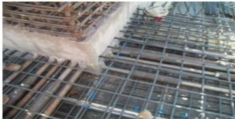
(A) Sambungan ke zona batas dinding geser
