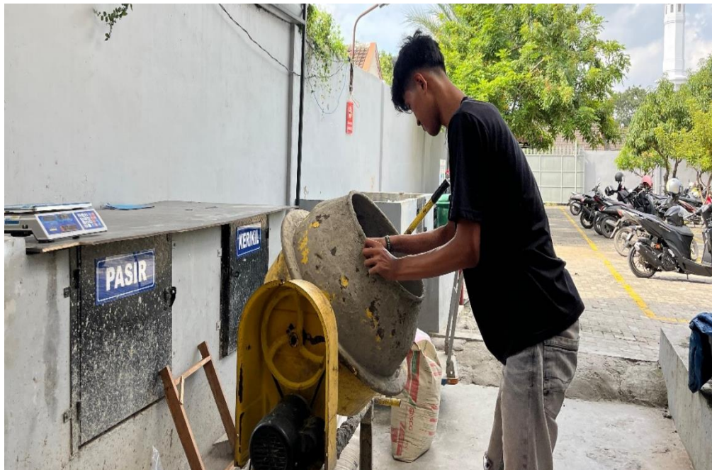
Gambar L3: Mencampur adonan beton
