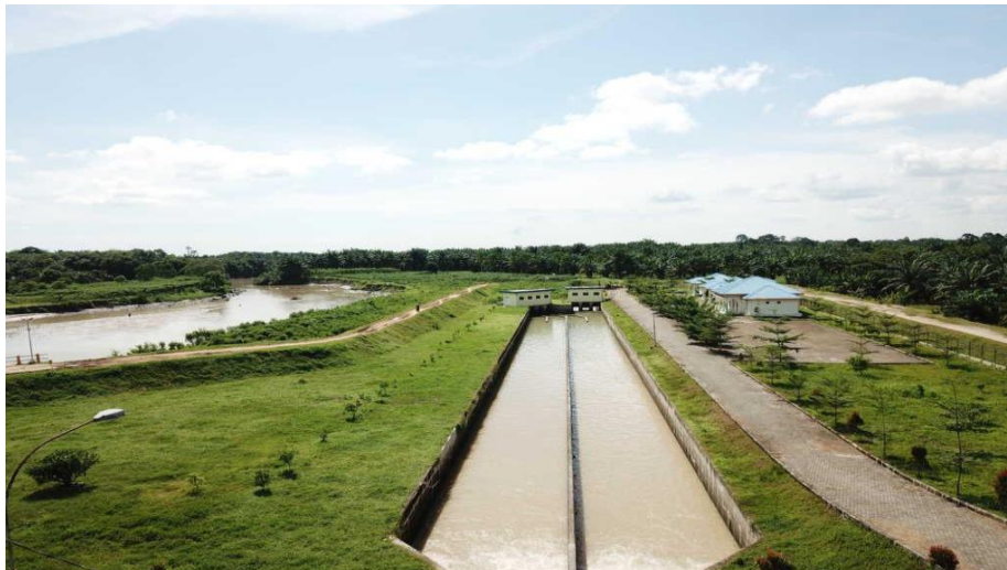
Gambar 4.1 Saluran intake menuju Desa Paya Pasir
