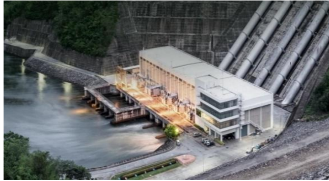
Gambar 2.6 Pembangkit Listrik Tenaga Air
