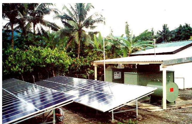
Gambar 2.11 Pembangkit Listrik Tenaga Hybrid
