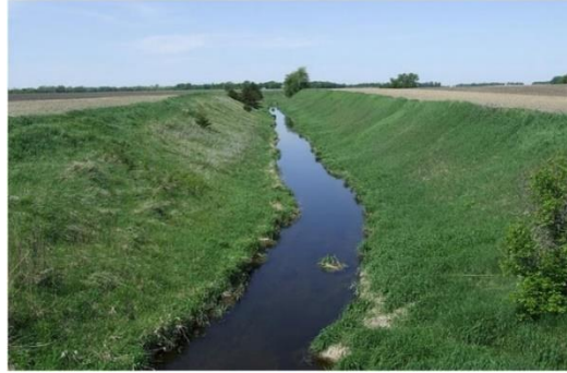
Gambar 2.1 Saluran Drainase Alami.
