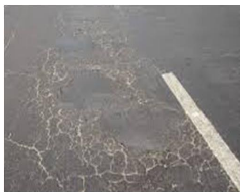
Gambar 2.21 Mengembang (Bina Marga, 1983).
