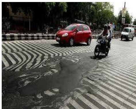
Gambar 2.8 Keriting (Bina Marga, 1983).
