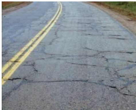
Gambar 2.13 Retak memanjang (Bina Marga, 1983).
