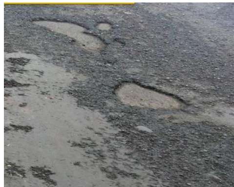
Gambar 2.7 Cekungan (Bina Marga, 1983).
