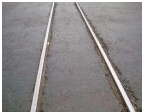
Gambar 2.17 Perpotongan Rel (Bina Marga, 1983).
