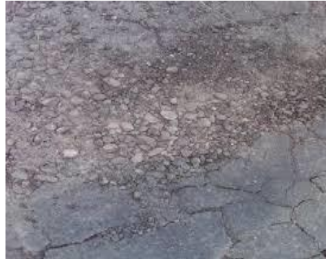
Gambar 2.22 Pelepasan Butir (Bina Marga, 1983).
