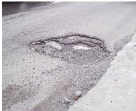
Gambar 2.16 Lubang (Bina Marga, 1983).
