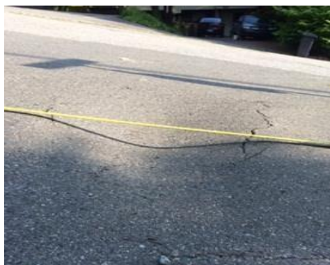
Gambar 2.9 Amblas (Bina Marga, 1983).
