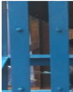
Gambar 3.8. Pelat Besi Dudukan Inverter
